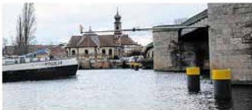
Dieses Frachtschiff fährt in der richtigen Spur unter der Alten Mainbrücke in Kitzingen. Kommt es dennoch von der Fahrtrinne ab, kann es die Brückenbögen nicht mehr rammen. Der neue Anprallschutz in Form der gelb gekennzeichneten Stahlrohre verhindert das. FOTO: CAROLINE MÜNCH
