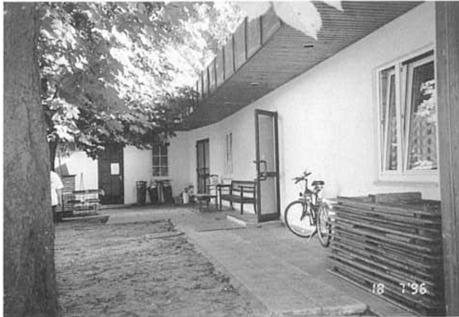
Die Baumaßnahmen sind fertiggestellt
