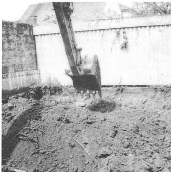
Fundamente werden ausge- baggert
