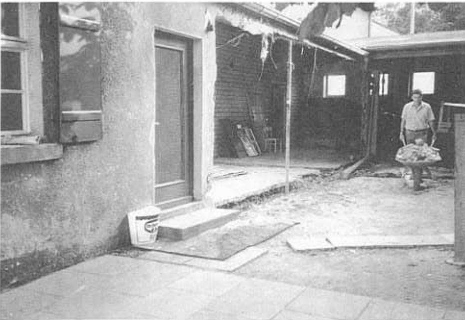
Der 2. Bauabschnitt beginnt.
