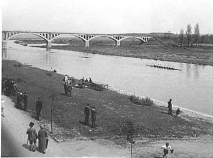
Welch schönes Bild mit der Gerolzböfer Eisenbahnbrücke im Hintergrund
